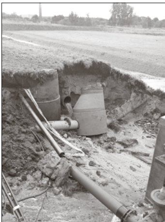
Gelände Nettolager - weggespülter Regenwasserschacht, gefährdete Trinkwasserleitung
