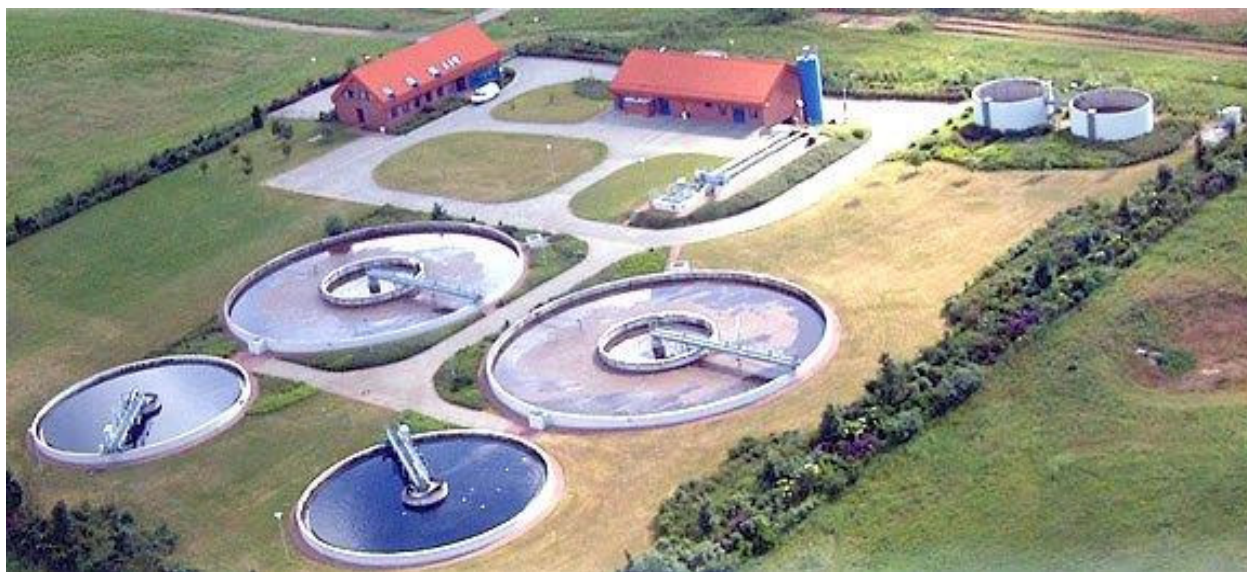
Kläranlage Coswig (Anhalt)
