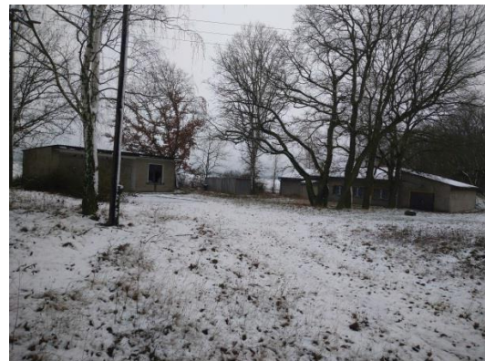
Abb.: Außengelände der Anlage
